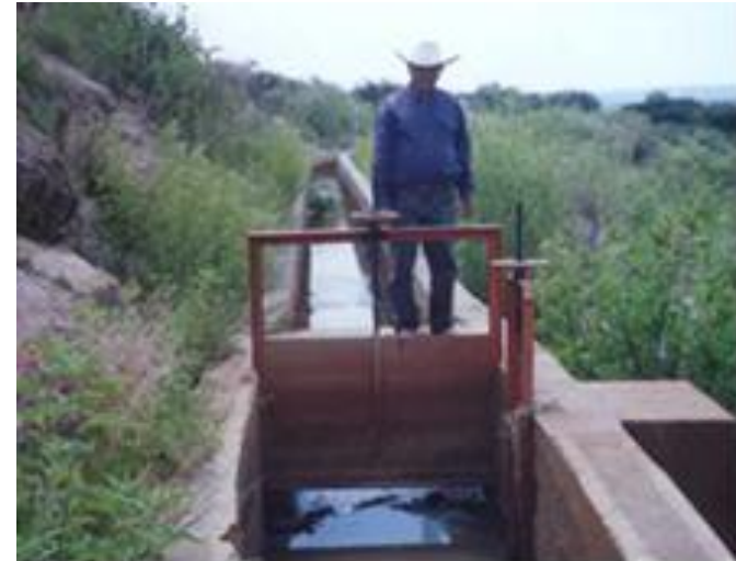
Represa en canal principal margen izquierda
