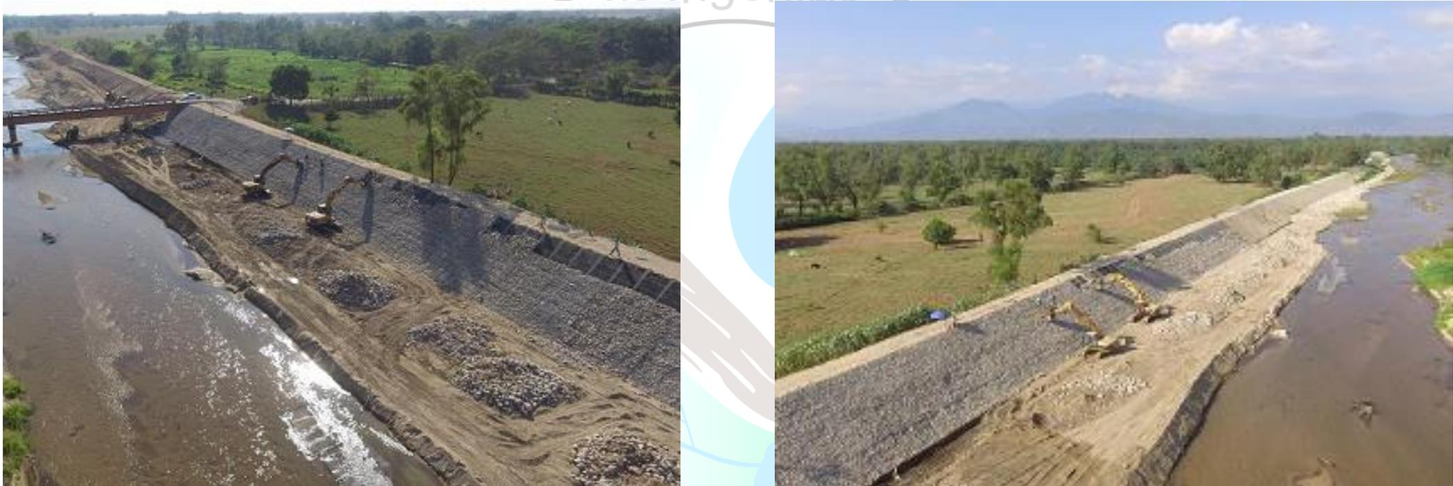
Reconstrucción de bordo, barrote natural y desazolve en una longitud aproximada de 7.0 kilómetros del cauce del río novillero, a la altura del puente del camino central, municipio de Mapastepec, Chiapas.
