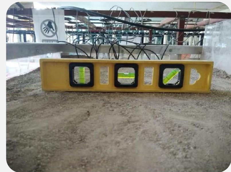
Figura 7. Nivelación de suelo
