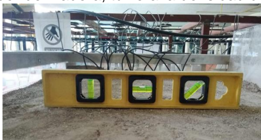
Figura 4. Instalación, nivelación y verificación del correcto funcionamiento de los sensores.
