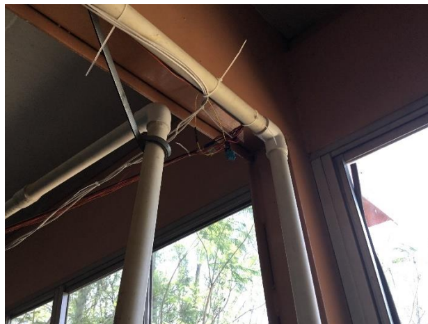
Figura 4. Ubicación del sensor DHT en una esquina del sistema de riego.
