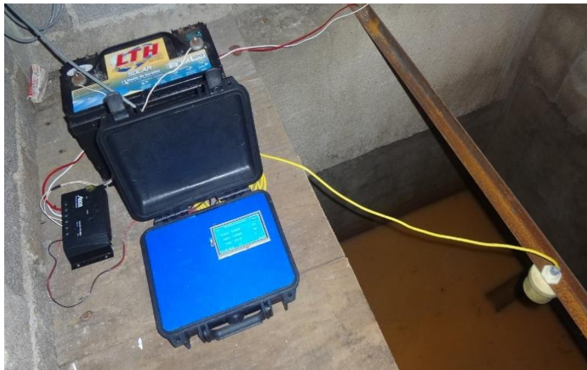
Figura 3. Equipo con sensor ultrasónico para el registro de los escurrimientos.
