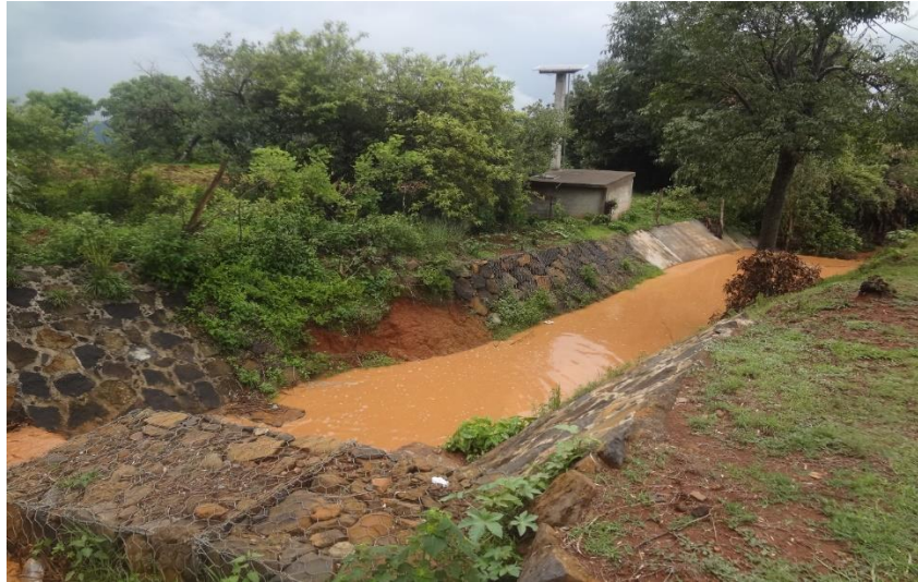
Figura 2. Aforador de garganta larga para medición de los escurrimientos.
