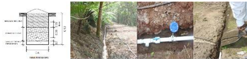
Figura 8. Diseño e instalación de la red de distribución hidráulica para riego de agua procedente del embalse.
