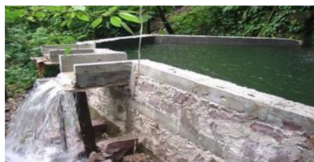
Figura 14. Embalse con rebosaderos de liberación de excedentes de agua para no afectar trayectoria de caudales de aguas subterráneas, conservación del ecosistema del BMM y abastecer sistema de riego gravitacional.
