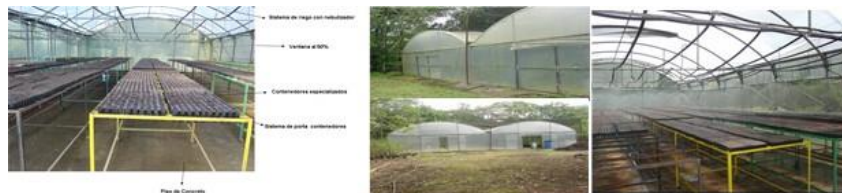
Figura 11. Invernaderos tipo multi túneles de estructura metálica para la producción tecnificada en contenedores BCC para plántulas de C. frutescens Var. Irish poblana y riego de nebulización.
