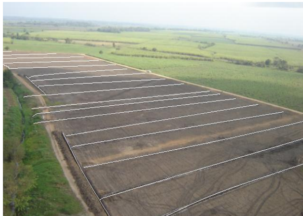
Figura 8. Instalación del sistema de drenaje.
