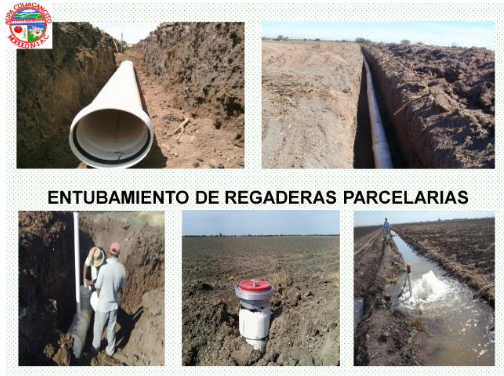
Figura 8.- Entubamiento de canales en el Módulo IV-1 “Culiacancito” A.C
