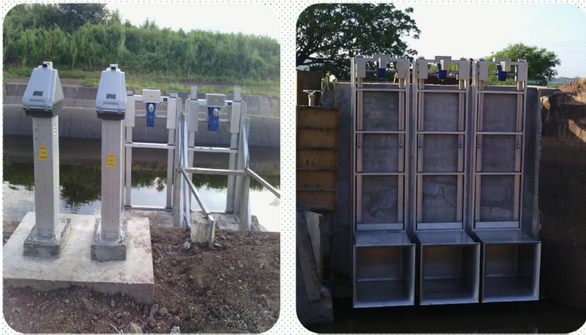
Figura 3.- Compuertas automatizadas en los canales laterales km 37+320 y 25+672 del Canal Principal Humaya, que abastecen al Módulo de Riego “Culiacancito” A.C.
