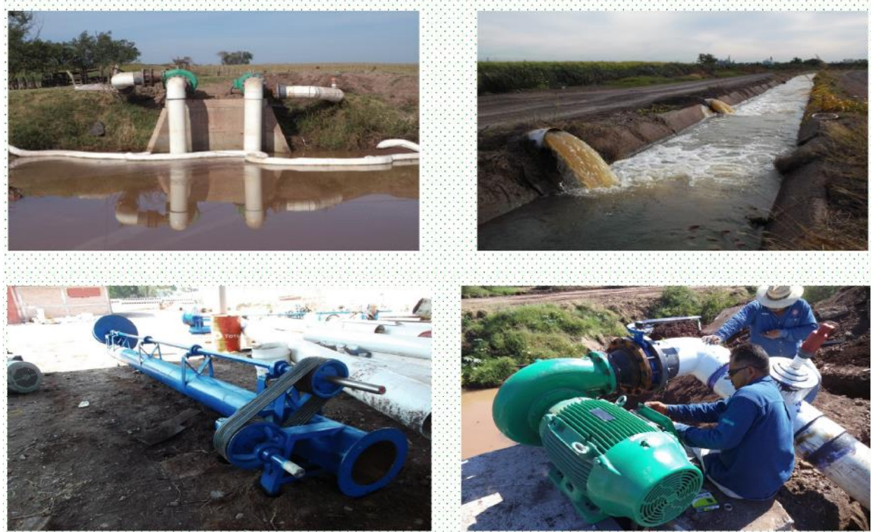
Figura 4.- Plantas de bombeo instaladas para la recuperación de agua de reuso en el Módulo de Riego “Culiacancito” A.C.
