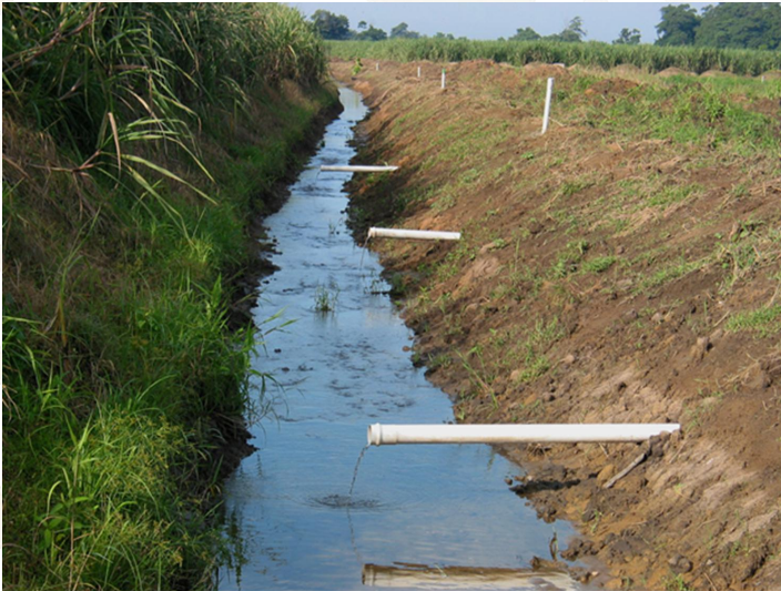
Descarga de los excedentes agua de los drenes subterráneos.
