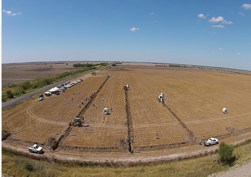
Instalación de un sistema de drenaje subterráneo parcelario
