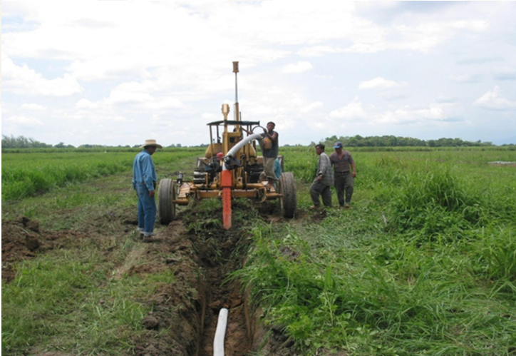
Instalación del sistema de drenaje subterráneo controlado.
