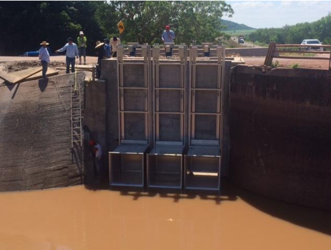
KM 0+000 Compuerta de Gasto Constante tipo SLIPMETER con control manual y automatización
