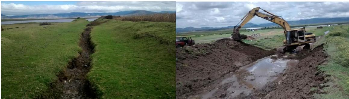
**Figura 1.** Trabajos de rehabilitación del canal de entrada al jagüey Novillos.
