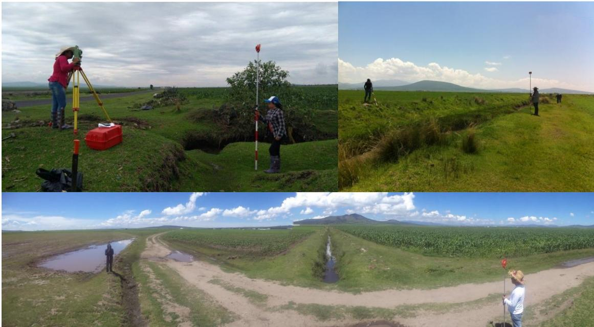
**Figura 3.** Topografía realizada en la red de drenaje de la zona de riego.
