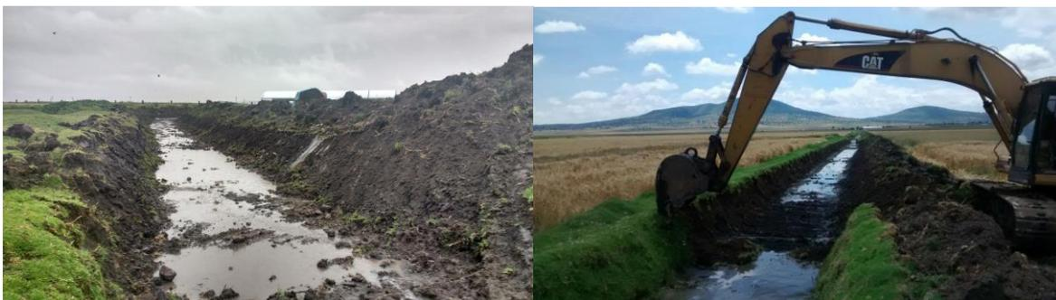
**Figura 6.** Trabajos realizados para la rehabilitación del canal de salida Novillos-Tochac.
