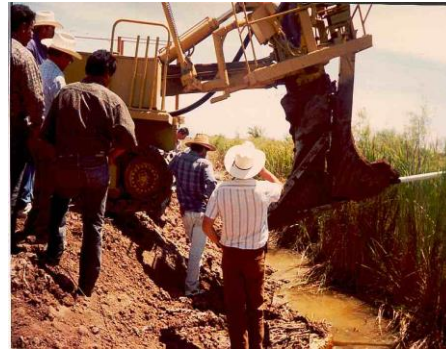
Figura 4. Instalación del sistema de drenaje en el lote 17 Ejido Nuevo Sinaloa
