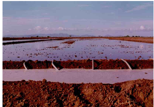
Figura 6. Aplicación de la primera lámina de lavado en la parcela piloto
