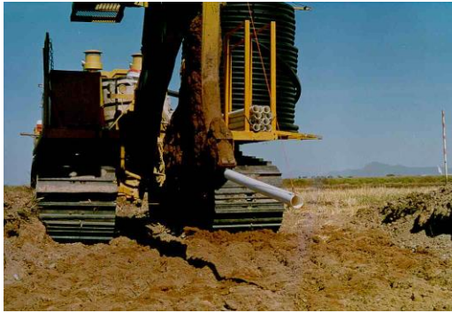
Figura 4. Instalación del sistema de drenaje en el lote 17 Ejido Nuevo Sinaloa
