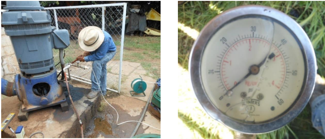
Figura 2. Medición de los niveles de bombeo con sonda eléctrica (izquierda); Manómetro tipo Bourdon (derecha)
