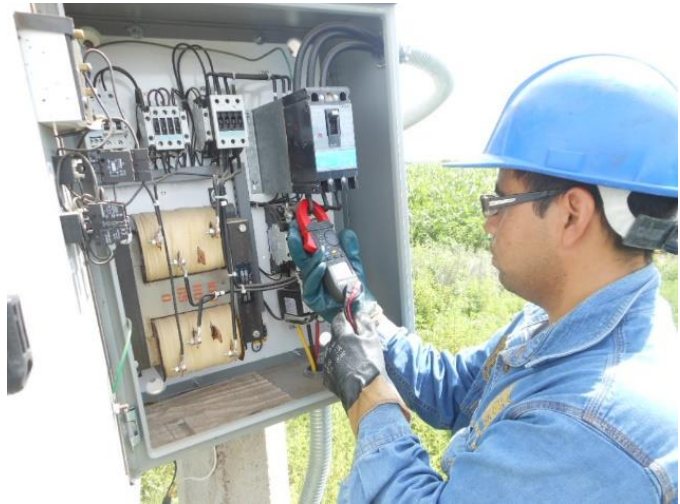
Figura 4. Analizador de corriente (izquierda); Medición de los parámetros eléctricos (derecha)
