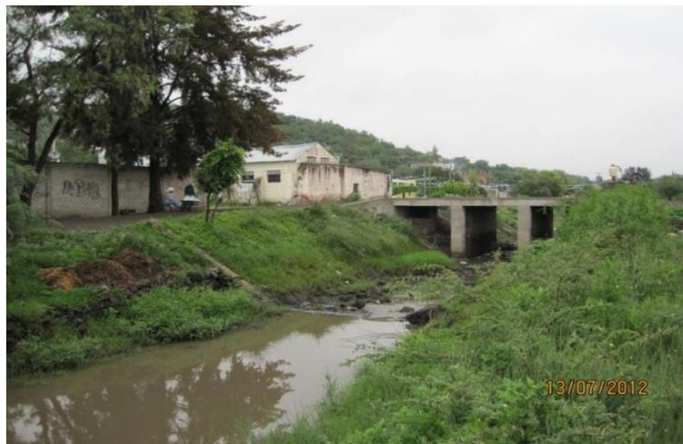
**Figura 1.** Canal sin revestir del módulo de riego 04, Valle de Santiago.
