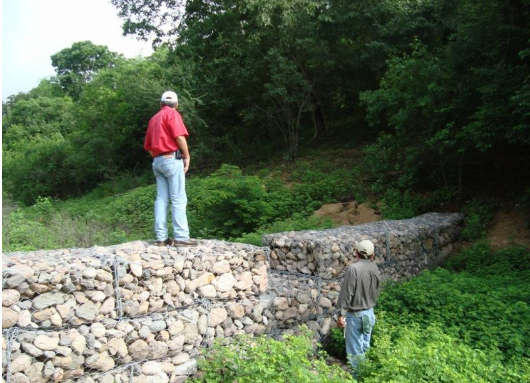
Figura 7. Presas filtrantes mediante gaviones.
