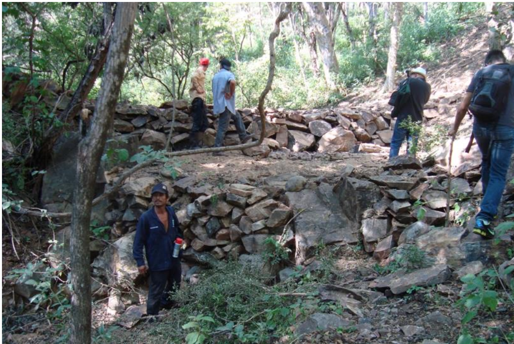
Figura 8. Presa filtrante con azolve acumulado y recuperación de suelos.
