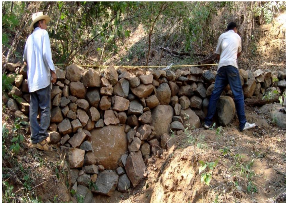
Figura 6. Presa filtrante de piedra acomodada.
