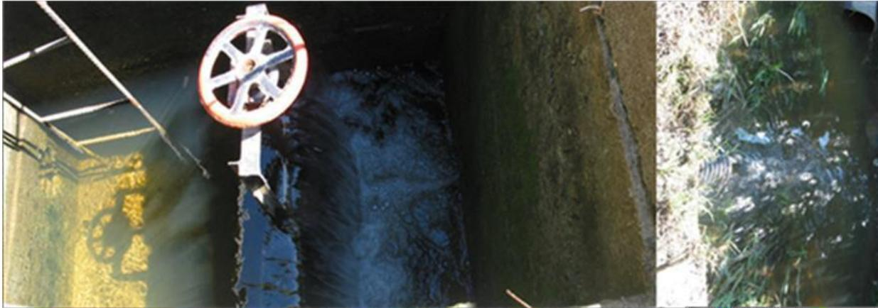
**Estructura de control, para el manejo del régimen de humedad en el suelo (Namuche *et al* 2003)**
