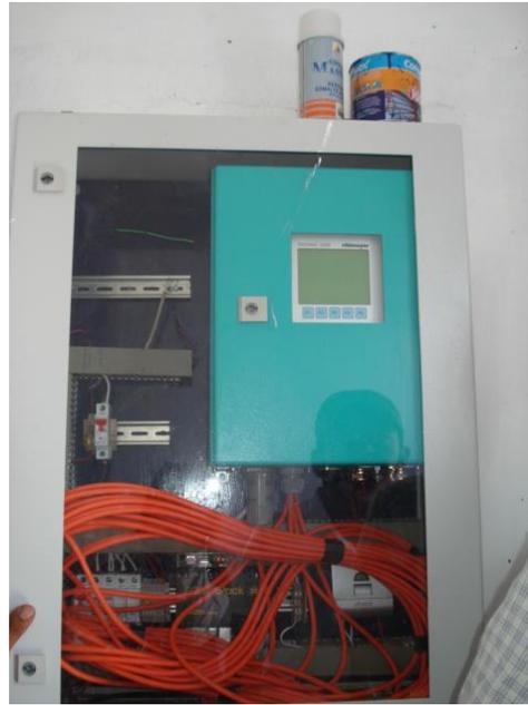
**Figura 3.** Aforador de tiempo de travesía
