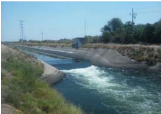
Figura 1. Vista del aforador de Garganta larga, instalado en El Carrizo, Sinaloa, México
