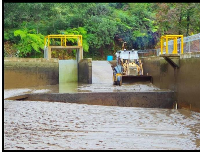
**Figura 9.** Salida del desarenador y rampa de acceso.
