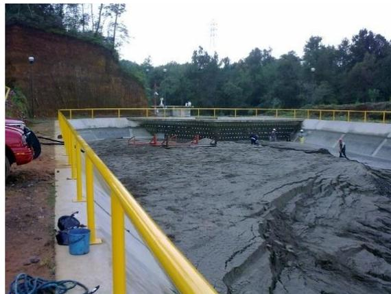
Figura 2. Azolve tanque regulador
