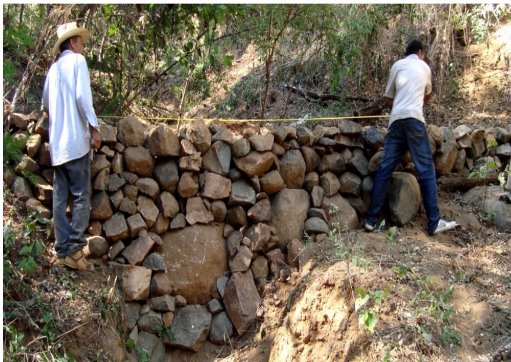
Figura 6. Presa filtrante de piedra acomodada.
