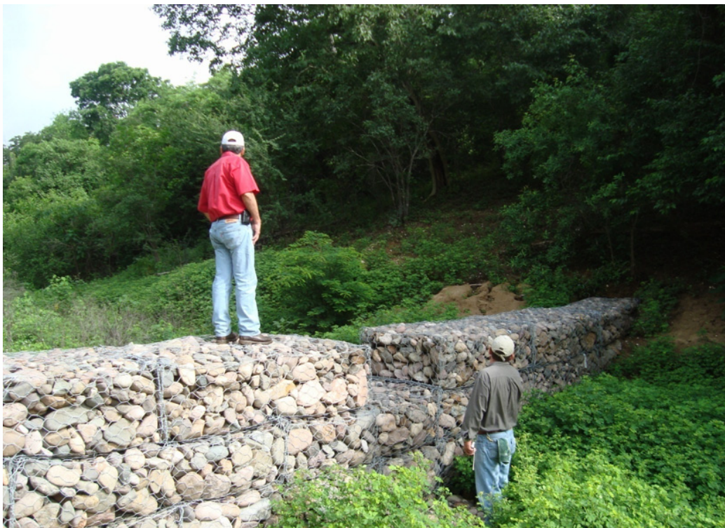
Figura 7. Presas filtrantes mediante gaviones.
