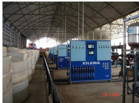
**Figura 8.** Cabezal de riego para invernaderos, Cruz de Elota, Sinaloa.
