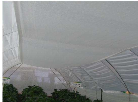
**Figura 10.** Manta térmica o doble capa. Expo Agropecuaria Irapuato, Guanajuato.
