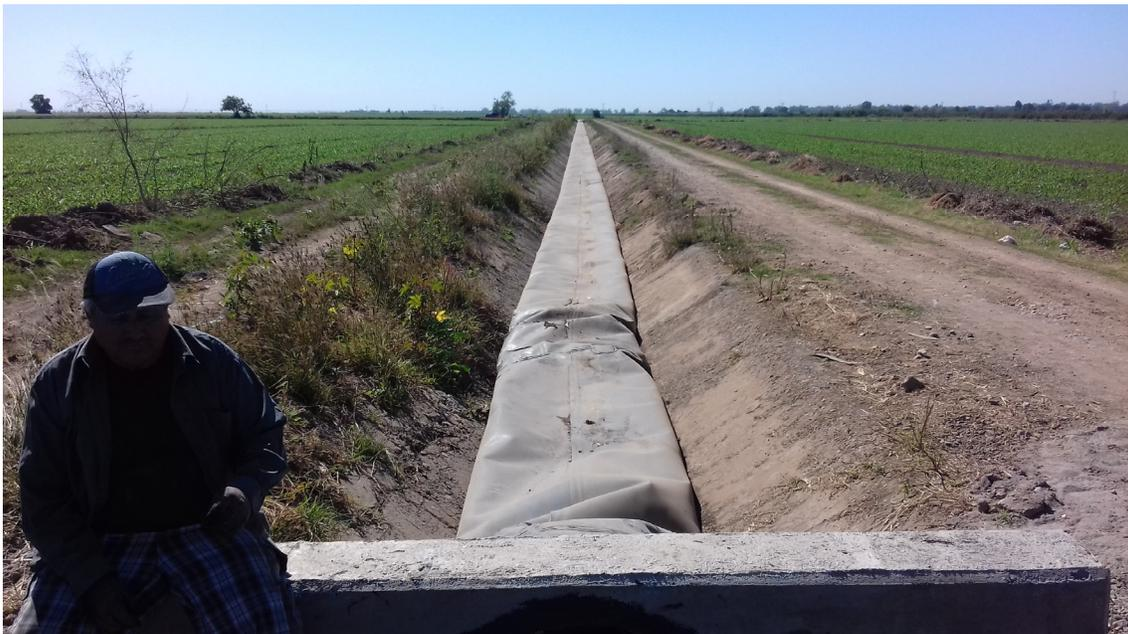
**Figura 6.** Situación después de geomembranizar el canal.
