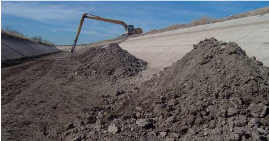
**Figura 4.** Excavadora hidráulica de brazo largo desazolviendo un canal de riego principal.
