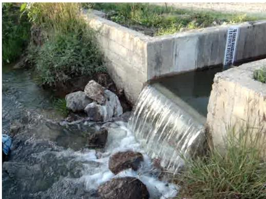
**Figura 7.** Medición con vertedor
